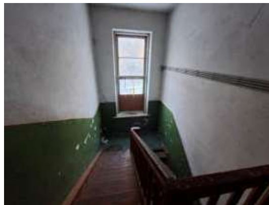
2.stāva kāpņu telpa
