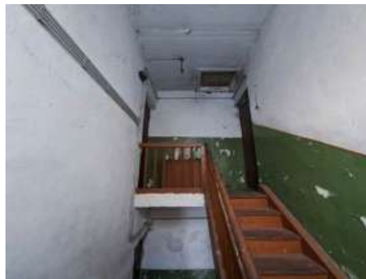
2.stāva kāpņu telpa
